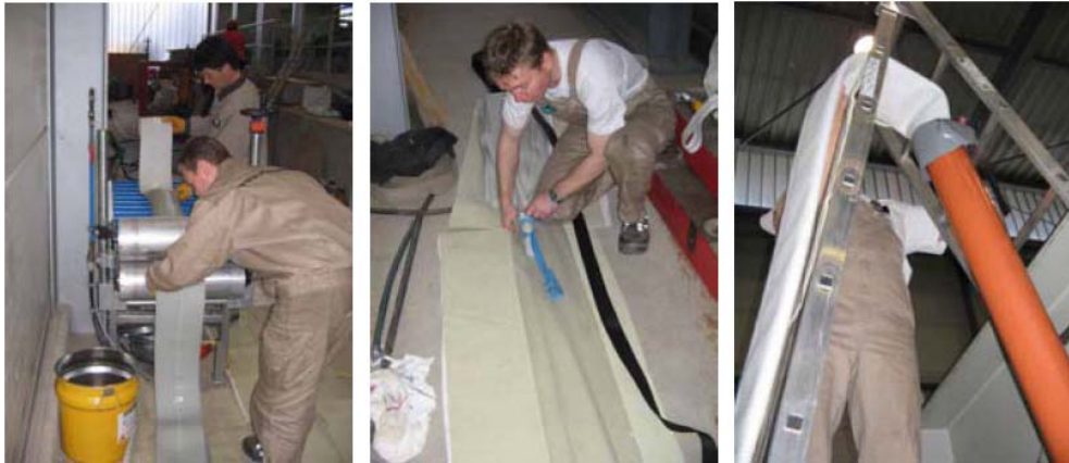
Abb. 1: Einbau von Schlauchlinern im Großversuchsstand, Beispiel ProFlex Liner
