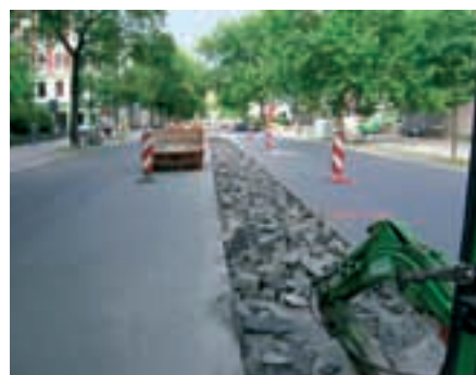
Abb. 1a–c: Typische Zerstörung einer neu aufgebauten innerstädtischen Straße (Berlin-Mitte-Tiergarten), Bau von Fernwärmeleitungen, die genauso gut grabenlos verlegbar sind
