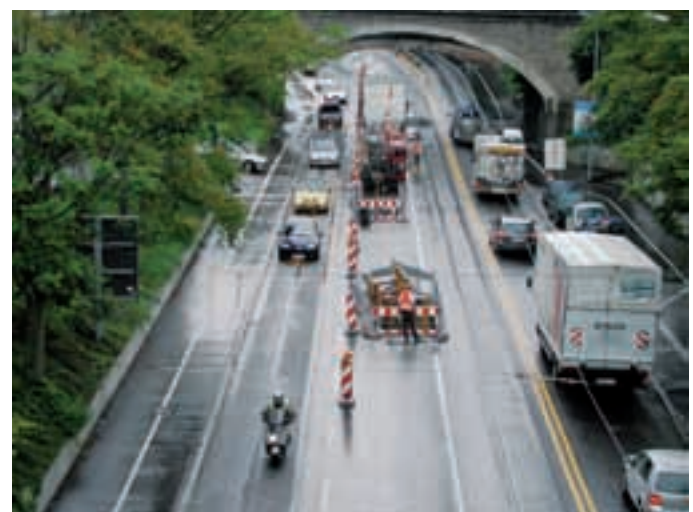
Abb. 4: Es geht auch anders: Gabenlose Leitungsverlegung in einer Hauptverkehrsstraße (Freiburg/Breisgau)
