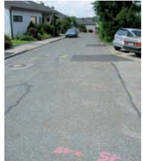
Abb. 14a, b: Typische Bilder von Straßen- und Gehwegoberflächen nach grabenloser Parallelverlegung von Erdgas- und Trinkwasserleitungen (Altbach/Neckar)
