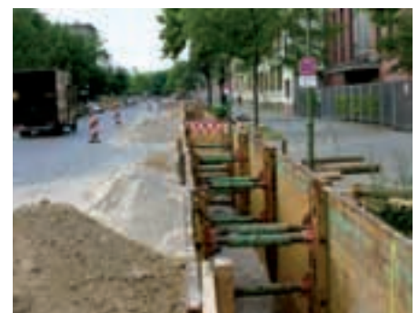
Abb. 1a–c: Typische Zerstörung einer neu aufgebauten innerstädtischen Straße (Berlin-Mitte-Tiergarten), Bau von Fernwärmeleitungen, die genauso gut grabenlos verlegbar sind
