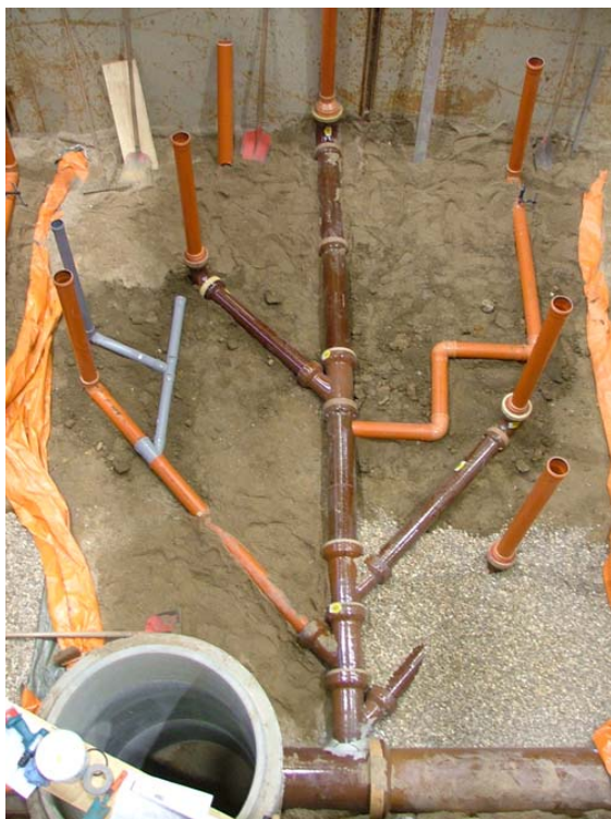
Abbildung 1: Versuchsnetz im IKT-Großversuchsstand für den Einsatz von Inspektionssystemen und Flutungsverfahren, vor Bodeneinbau
